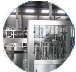
Archivado de enfriamiento
