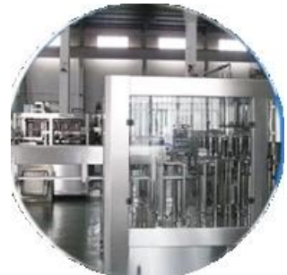
Archivo de enfriamiento
