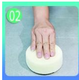
02 Polaco con cera de baldosas, excepto la baldosa esmaltada.
