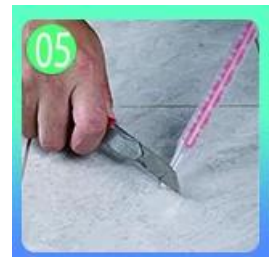
05 Corte inclinado la parte superior de la boquilla en 45°.
